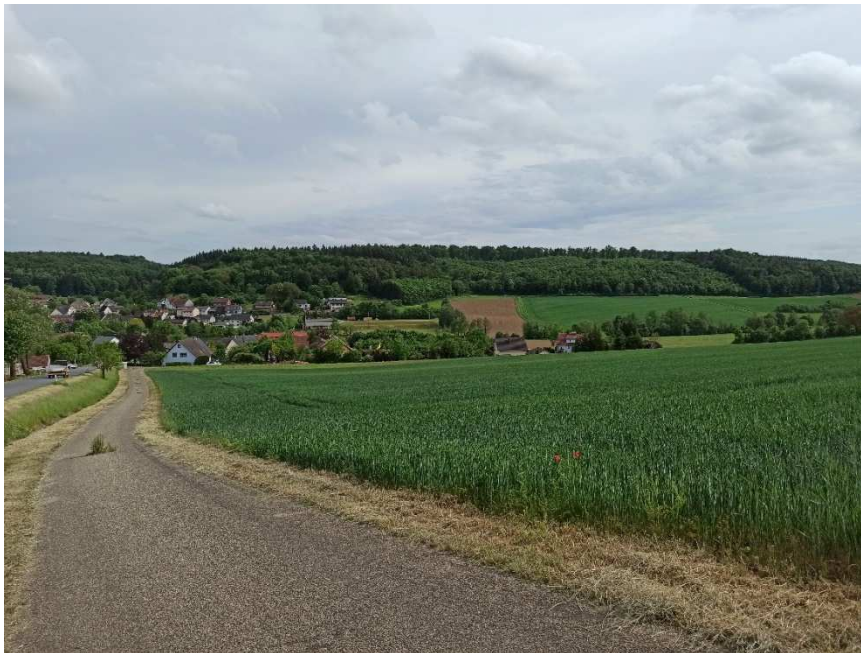
Abb. 4: Blick von Norden in Richtung Plangebiet mit angrenzendem Ortsrand
